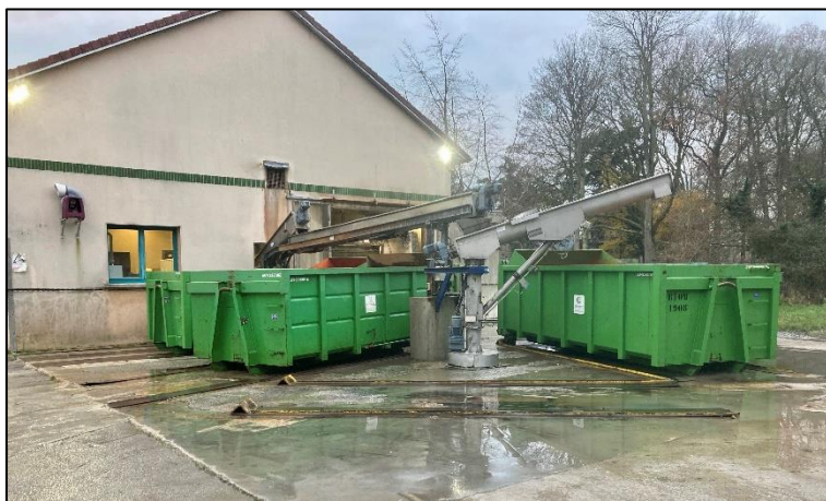
Photo n°1 : Caissons de stockage sur le site de la papeterie NORPAPER.
